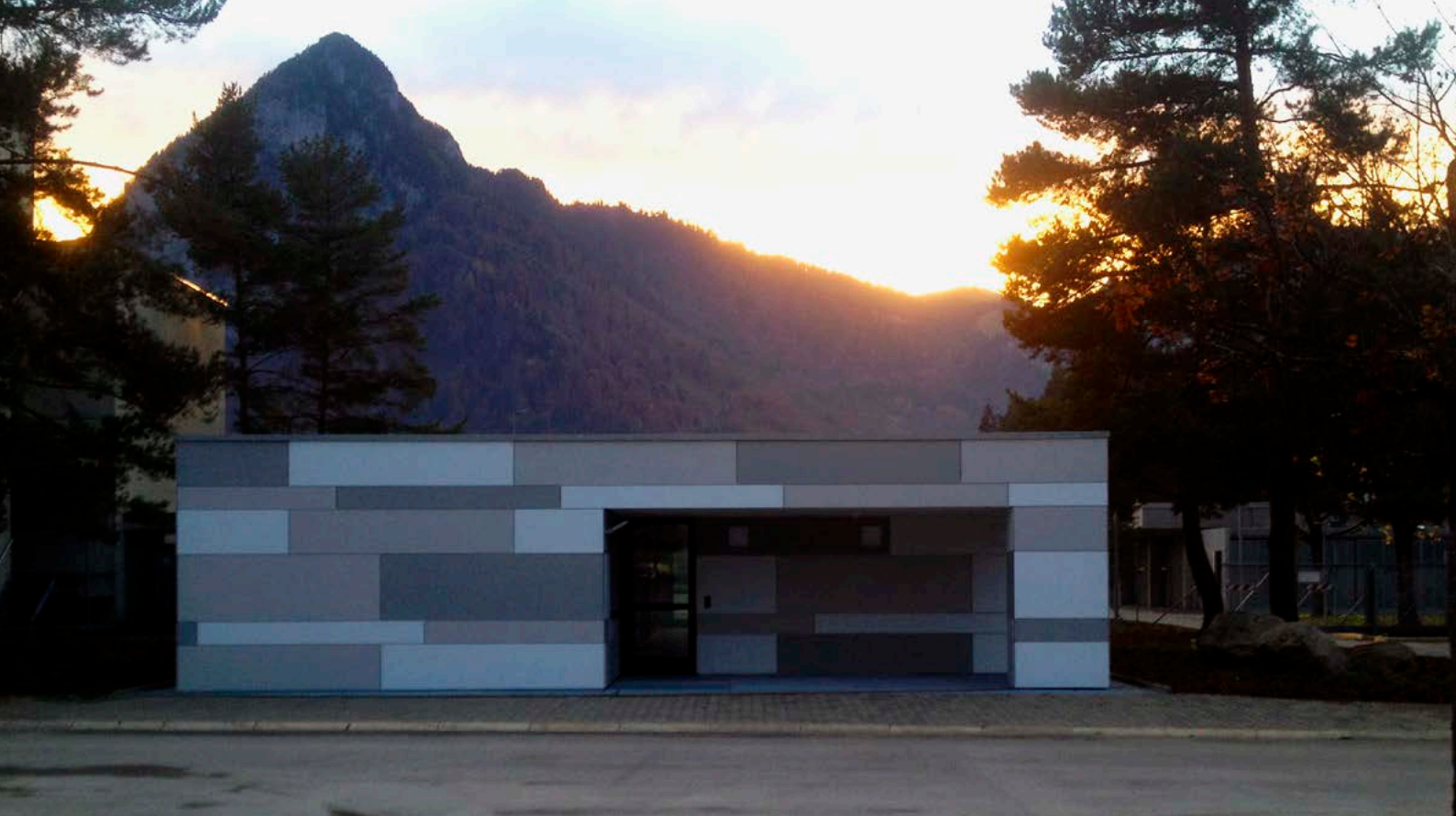
Eingang zur Probenannahmestelle
