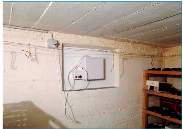
Radonsanierung mit Zusatzlüftung
