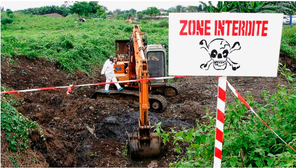
Sanierungsarbeiten an einem der belasteten Standorte
